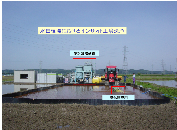
図1. 化学洗浄法によるカドミウム汚染水田の修復風景 (写真提供：農業環境技術研究所 牧野知之)
